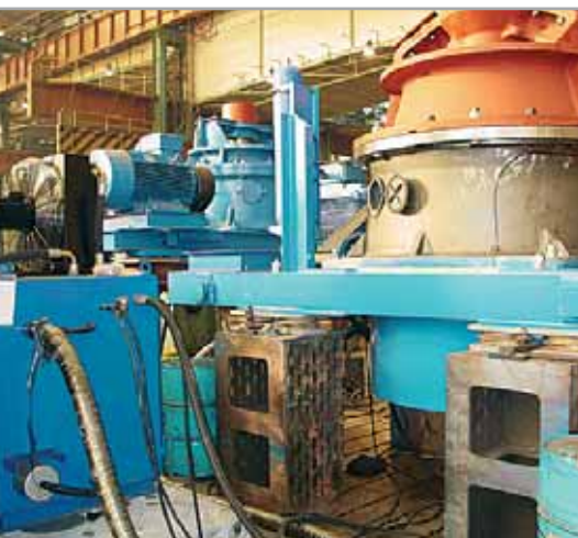
Montage de broyeurs à cône
